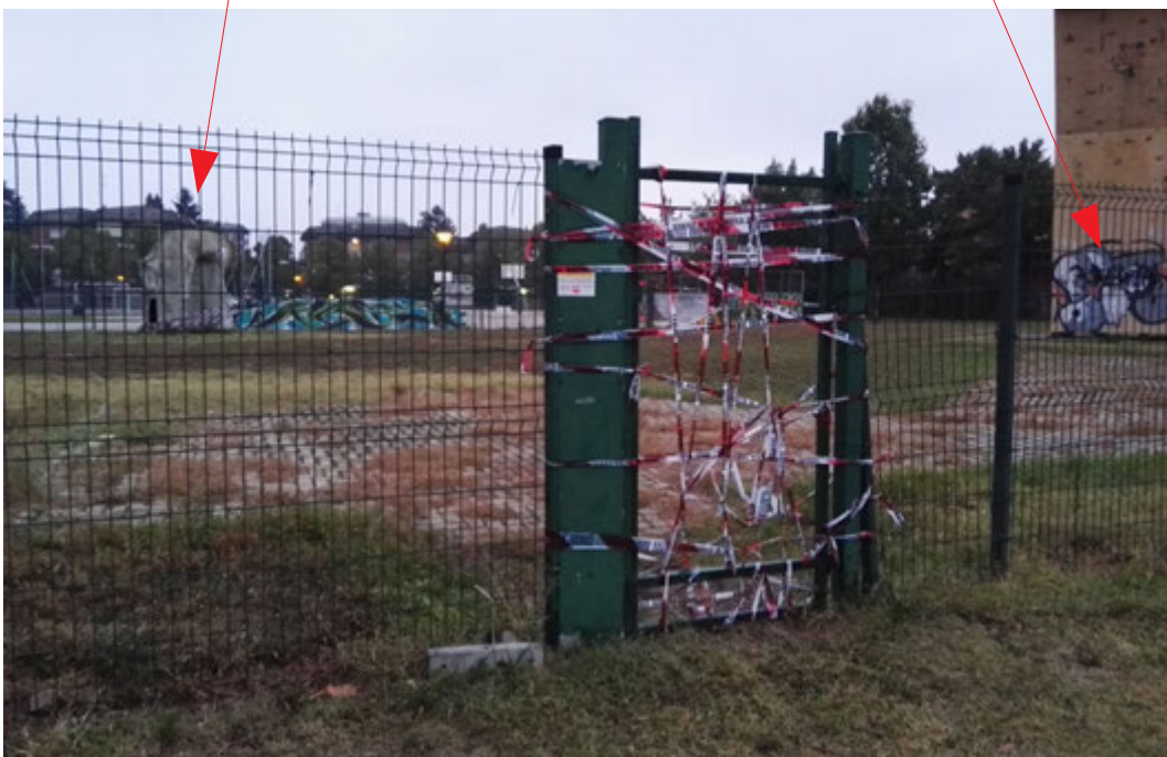
foto fatta in data 01/10/2018 ore 07:15 Ingresso Secondario
