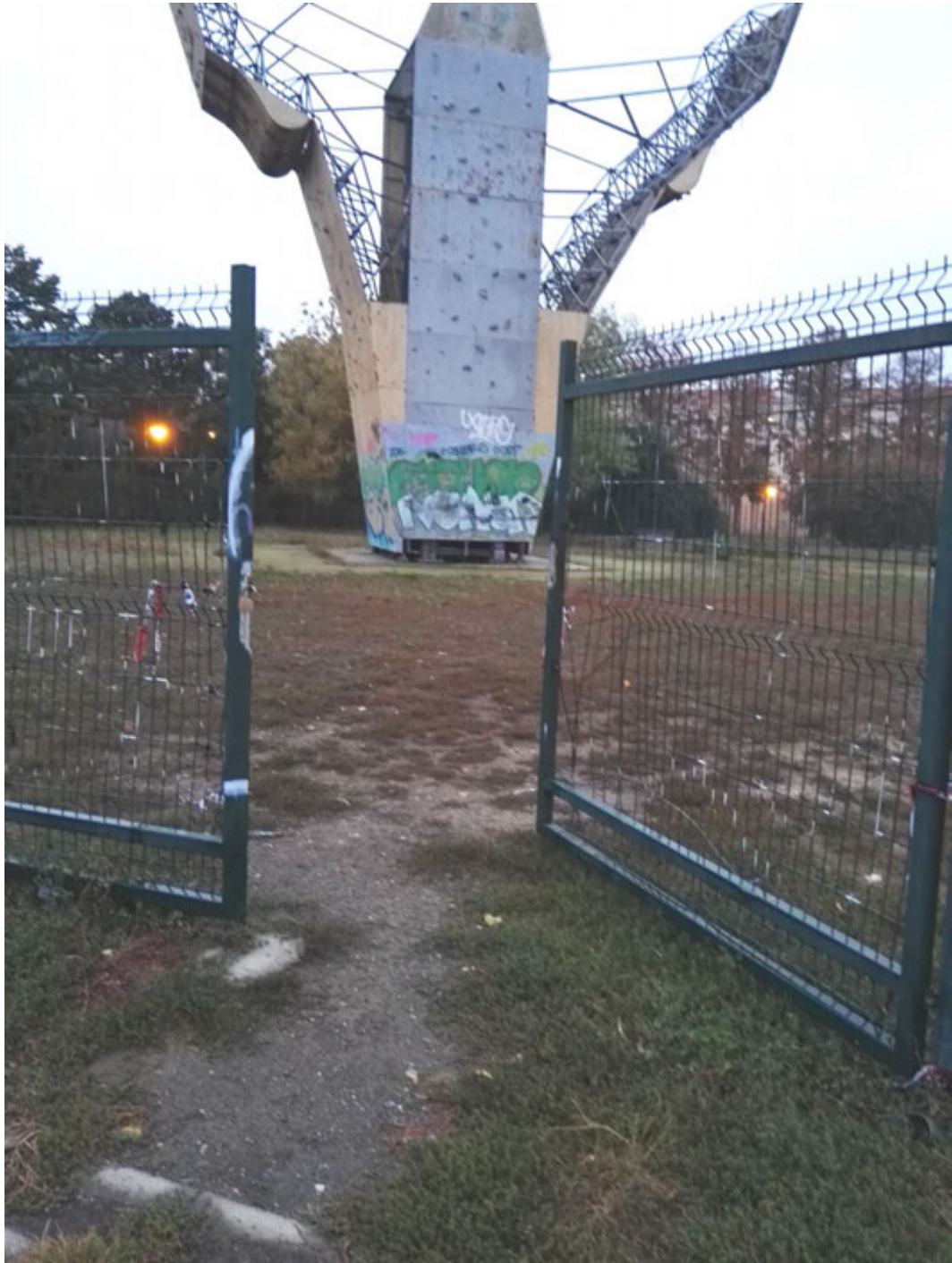
foto fatta in data 01/10/2018 ore 07:15 Ingresso Principale
